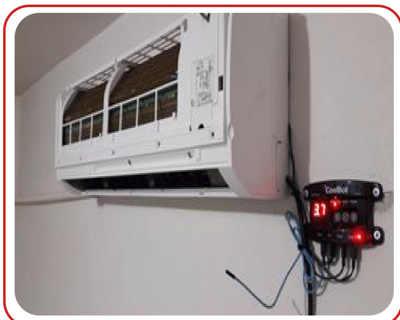
Conecte los cables en los puertos etiquetados correspondientes en la parte inferior del CoolBot Pro.
