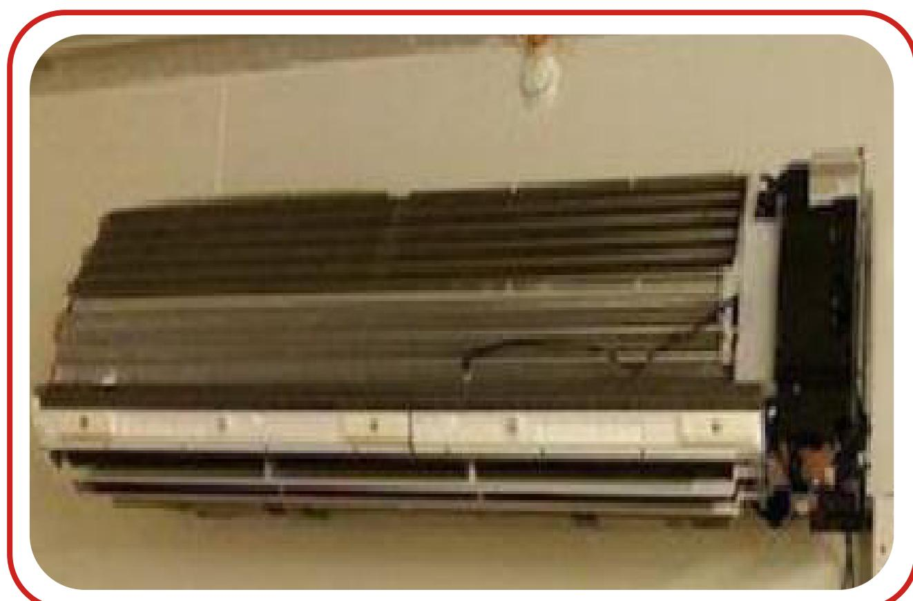
Limpie las aletas dos veces al mes. Retire toda la carcasa del mini split para exponer la unidad como se muestra en la imagen. Siga el manual de instrucciones de instalación del fabricante del aire acondicionado.
