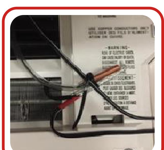
Encuentra y libera el sensor de pozo o secundario y libérelo del cilindro. Se deja como en la imagen, se puede unir con un cincho al sensor primario y cable calentador en esta zona.
