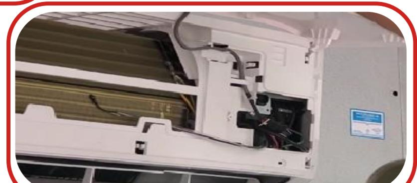
Libere el sensor de temperatura el aire acondicionado. Es lo único que se adjunta a las letas delanteras del aire. Déjelo de esta manera.
