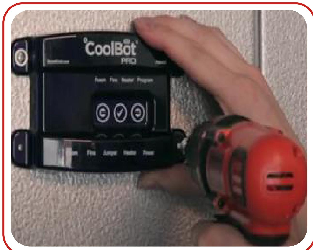
Fijar el CoolBot a un costado del minisplit, nunca debajo de la unidad, debido a que el escurrimiento de agua por condensación puede causar daños irreparables en el CoolBot.
