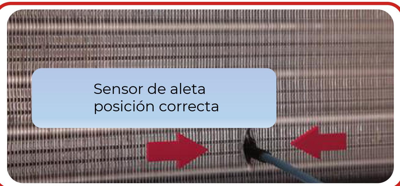
Use un bolígrafo para abrir un espacio de 5mm en la parte inferior de las aletas, centrada entre la primera y segunda tubería del serpentín, en la parte inferior.
