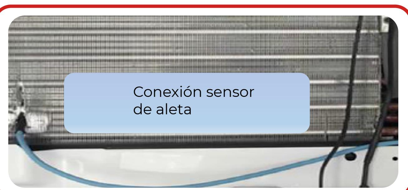
Tome el sensor de cable que viene del puerto CoolBot Pro con la etiqueta “aletas” e inserte solo 7 mm de la punta en el pequeño espacio.
